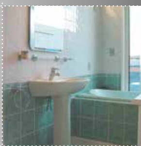
Installation salle de bain
