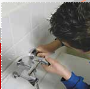
Raccordement mécanique d'une robinetterie
