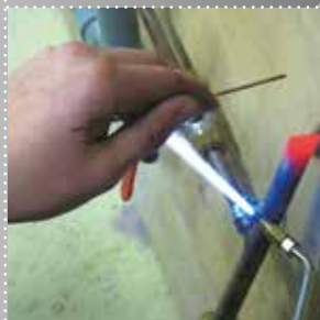
Raccordement par sondage
