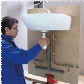
Raccordement des eaux usées
